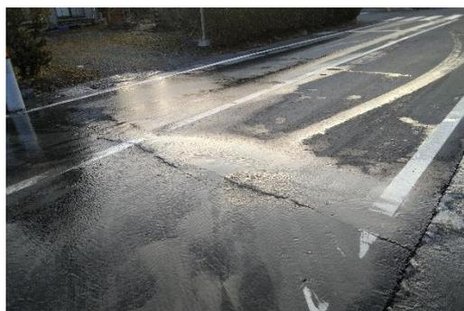
図表 10 地震による漏水被害
